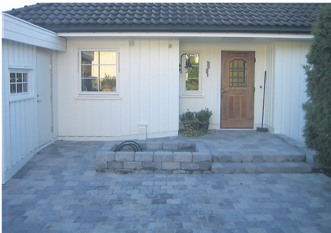
Her ser man et godt eksempel på hvordan et eldre ektepar har tilpasset inngangspartiet i sin enebolig med bistand fra Husbanken og NAV-Hjelpemiddelsentral.
