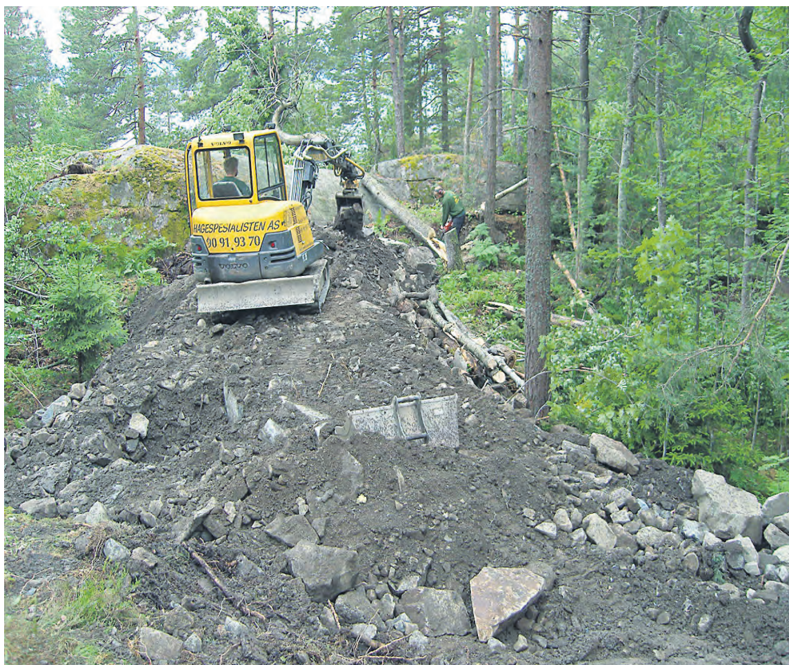
Slik så det ut mens arbeidet pågikk.
