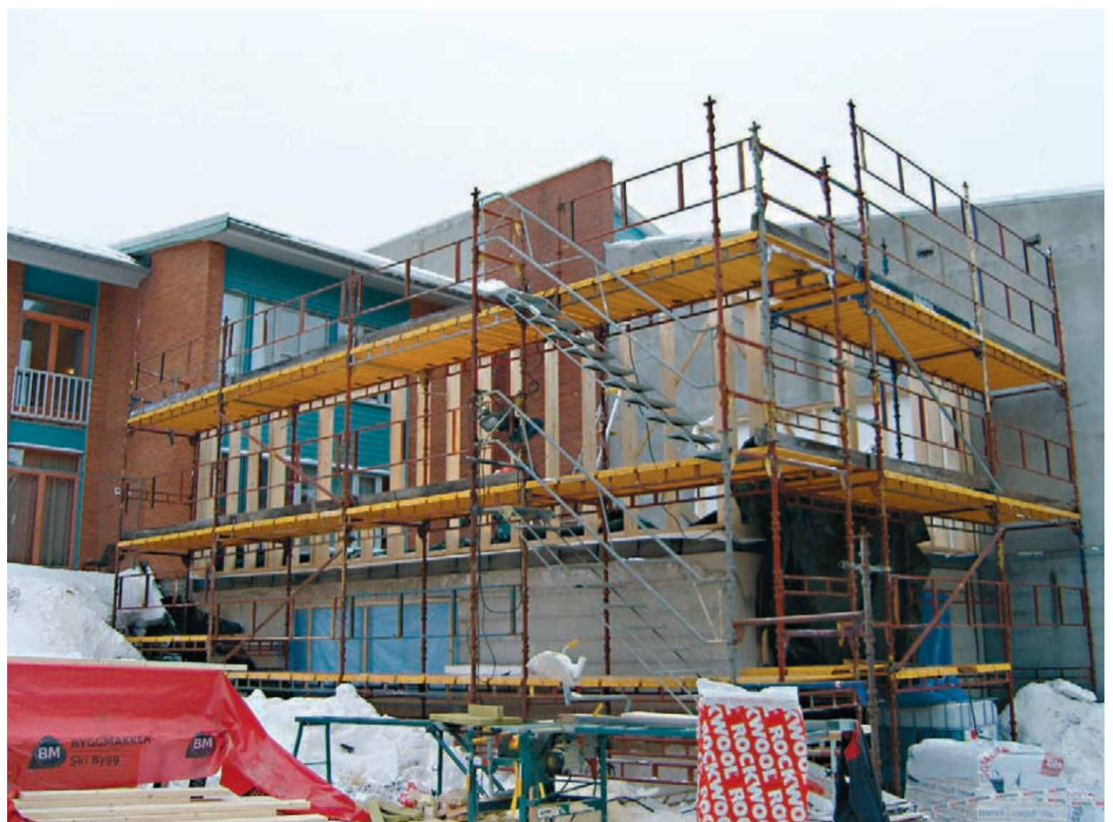
CatoSenterets utvidelse mot nordøst, på baksiden av svømmehallen, bygges det kontorer, behandlingsrom, treningsrom og lager. Her kommer det også en ny vei og flere parkeringsplasser.
